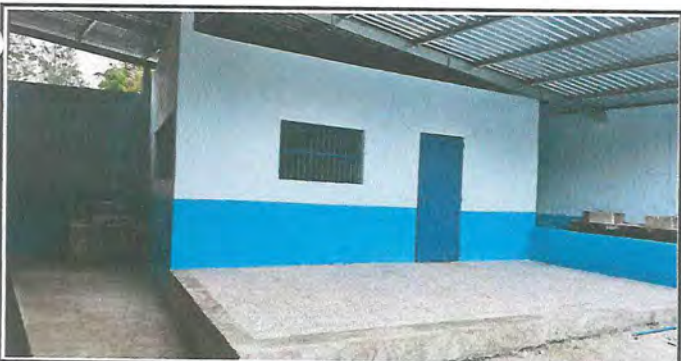
Foto 5: NIVELACION DE PAREDES EN AULA Y MURO PERIMETRAL
