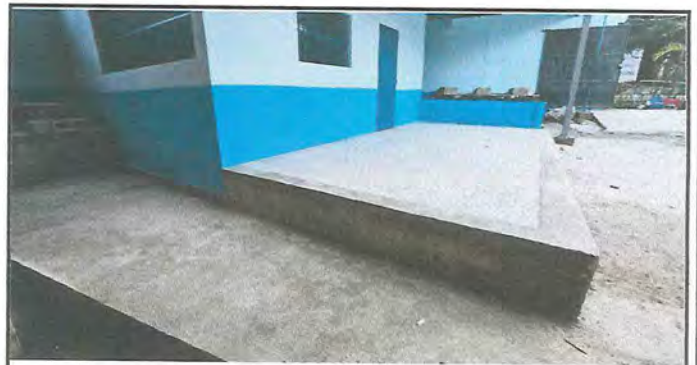
Foto 4: FUNDICION DE LOSA EN GRADA DE PATIO
