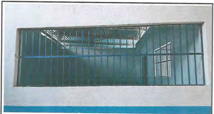
Foto 4: SUSTITUCION DE BALCONES
