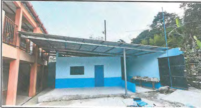
Foto1: APLICACIÓN DE PINTURA GENERAL
