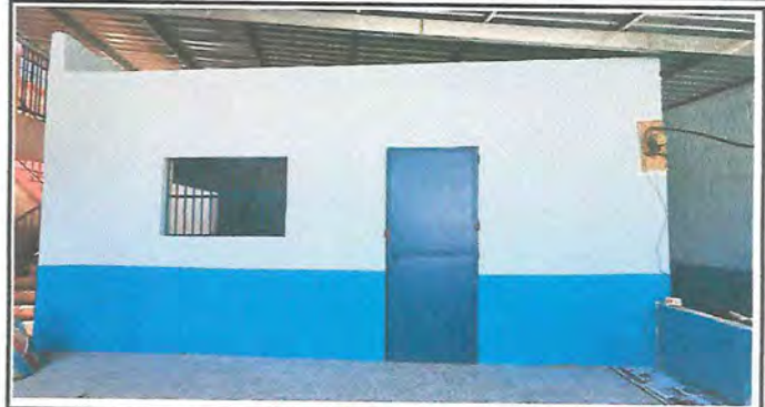
Foto 2: SUSTITUCION DE PUERTA DE AULA
