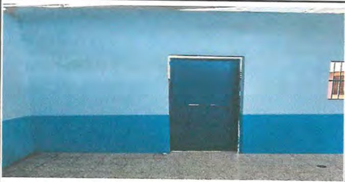
Foto 3: SUSTITUCION DE PUERTA DE AULA
