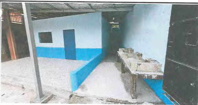
Foto 5: FUNDICION DE LOSA EN COCINA
