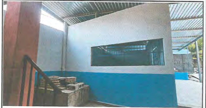
Foto 2: APLICACIÓN DE PINTURA GENERAL
