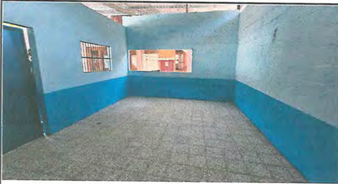
Foto 3: APLICACIÓN DE PINTURA GENERAL
