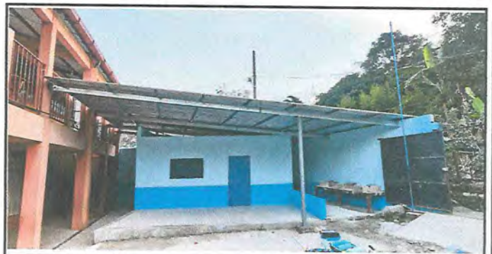
Foto 6: NIVELACION DE PAREDES EN AULA Y MURO PERIMETRAL
